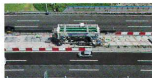
移動床版架設機を用いた現況車線確保による施工（イメージ）
