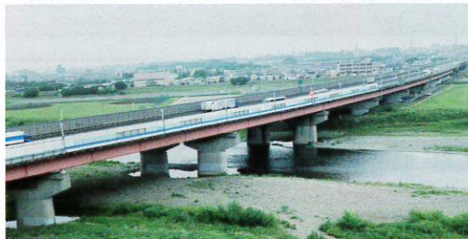
東名多摩川橋
