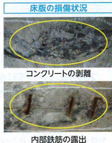
内部鉄筋の露出
